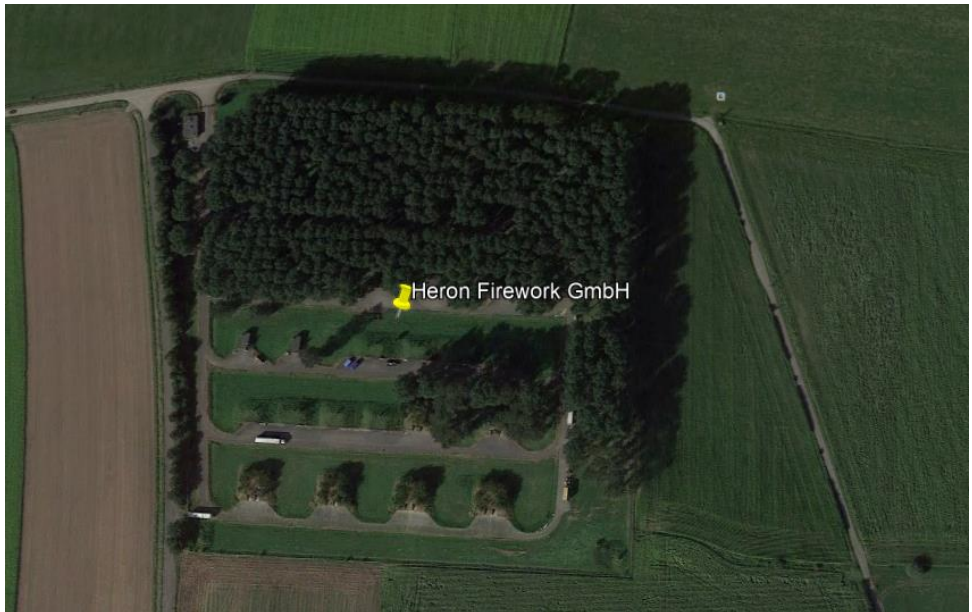
Satellitenbild der Lageranlage in Emmerich am Rhein (Quelle: GoogleEarth)
